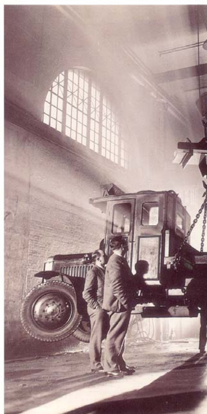
Les années 30. Test de vitrage SGG SECURIT®. Un camion, chargé de personnes, est suspendu à une feuille de verre trempé de 25 mm d'épaisseur. Le verre SGG SECURIT® résiste!
