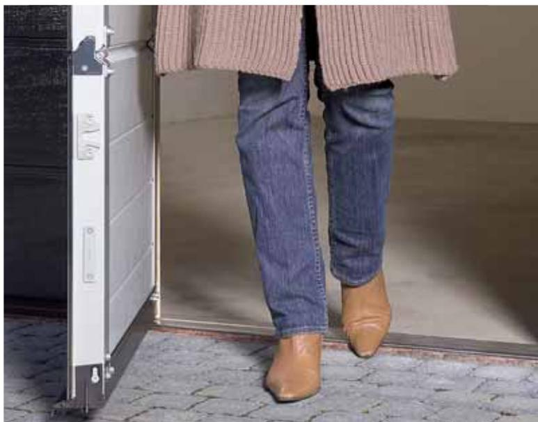
Désormais, avec le profil de seuil plat en acier inoxydable, 10 mm de haut au milieu et seulement 5 mm sur les côtés, le risque de trébuchement est limité et le passage des vélos est facilité.
